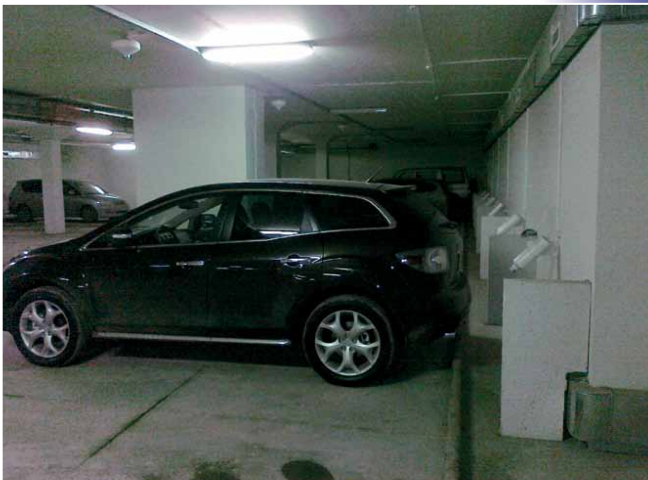
Пример расположения МПП «Ураган-1М» и МПП «Ураган-3» на подземной парковке, с учетом тушения «зон затенения» (подавтомобильные пространства). 2010 год.
