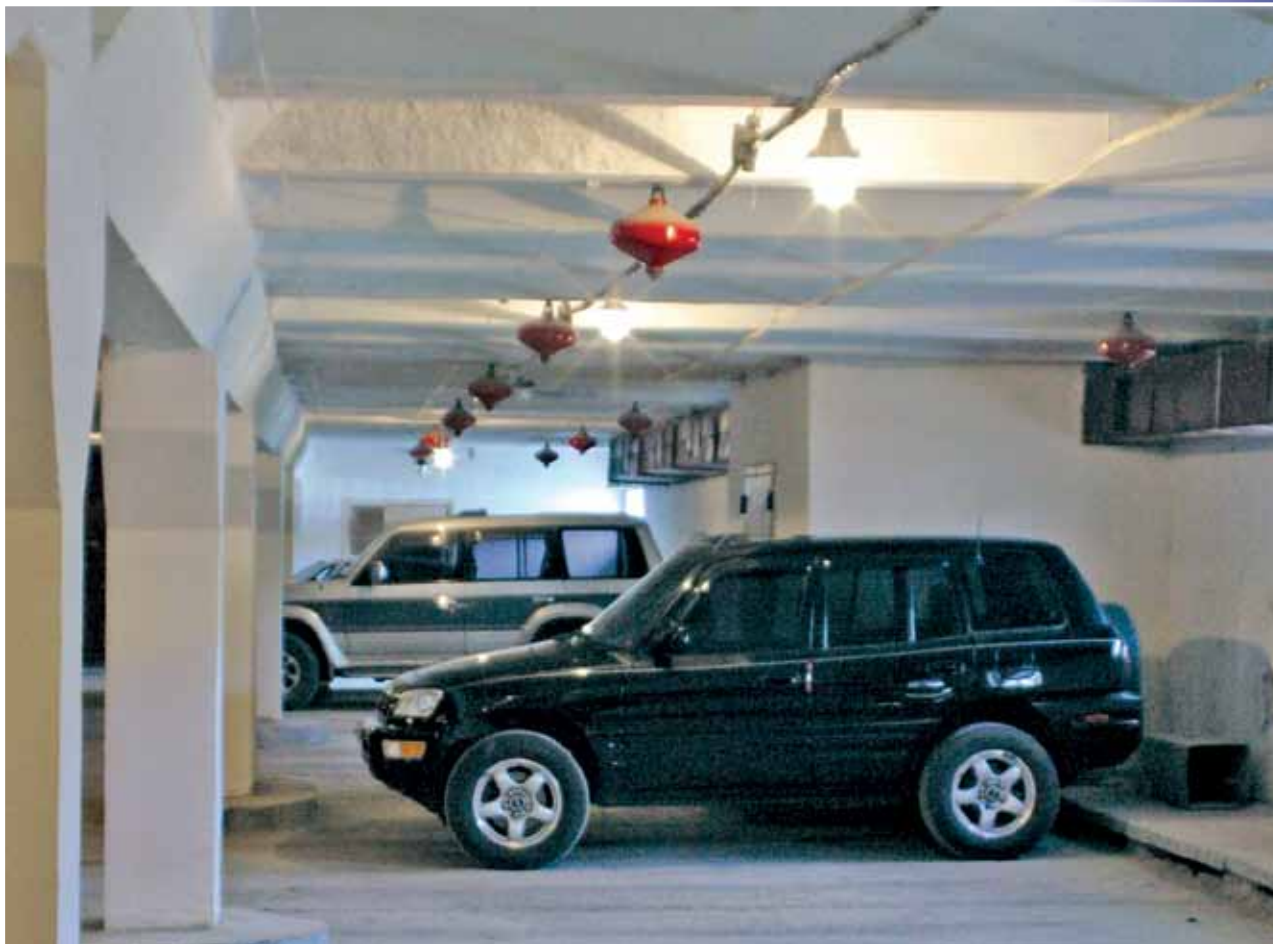
Пример расположения МПП «Ураган-1М» и МПП «Ураган-3» на подземной парковке, с учетом тушения «зон затенения» (подавтомобильные пространства). 2010 год.
